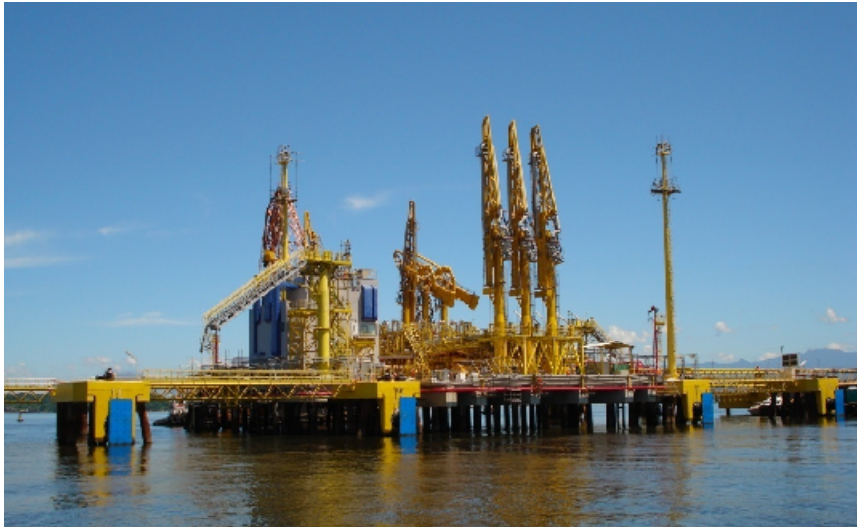
Pecem Pier / LNG Loading Arms and HP Gas Arms
